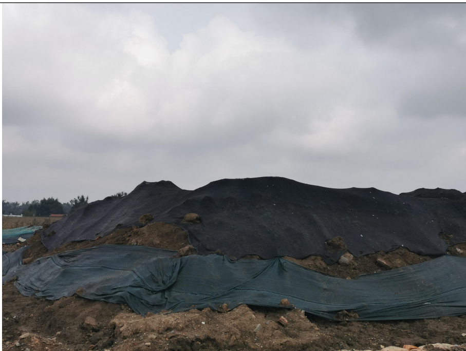
临时措施密目网苫盖
