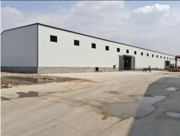
工程建设区完工后影像
