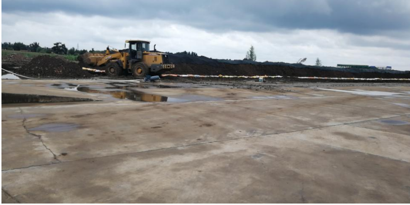
工程建设区表土剥离施工影像
