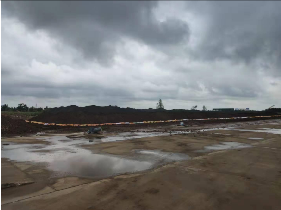
临时措施堆土拦挡
